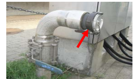
ELAFLEX-Kupplungen (nach Norm: EN 14 420-6 DN 50) Quelle: P. Sauter Port of Basel
