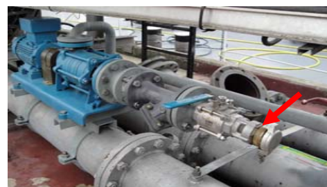
ELAFLEX-Kupplungen (nach Norm: EN 14 420-6 DN 50) Quelle: P. Sauter Port of Basel
