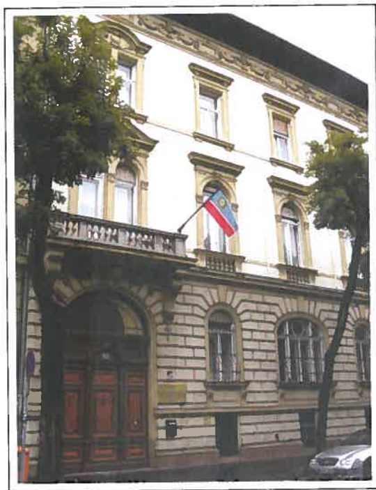
L'immeuble de la Commission du Danube à Budapest
