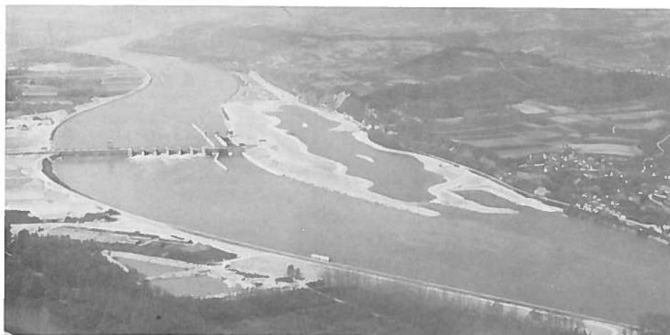
Centrale hydro-électrique de Melk (km 2038)
