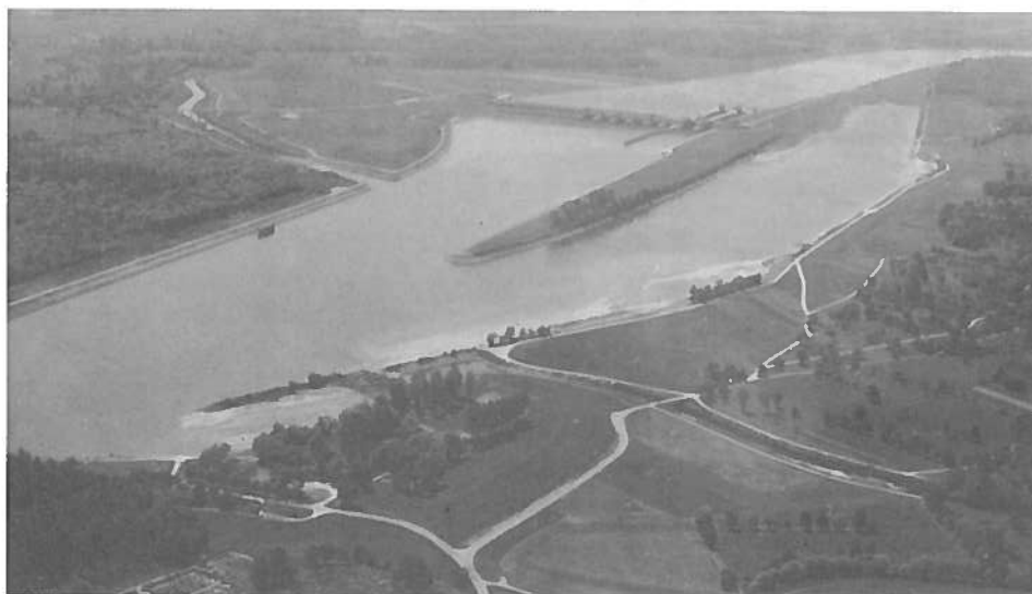
Centrale hydro-électrique d'Ottensheim (km 2146,8)
