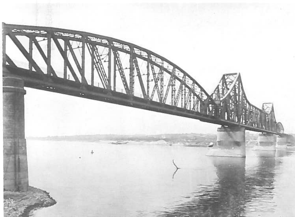
Pont sur le Danube à Cernavoda
