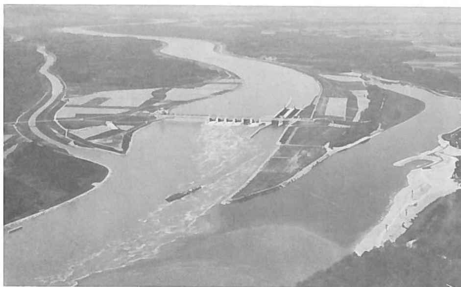
Centrale hydro-électrique d'Altenwörth (km 1980)
