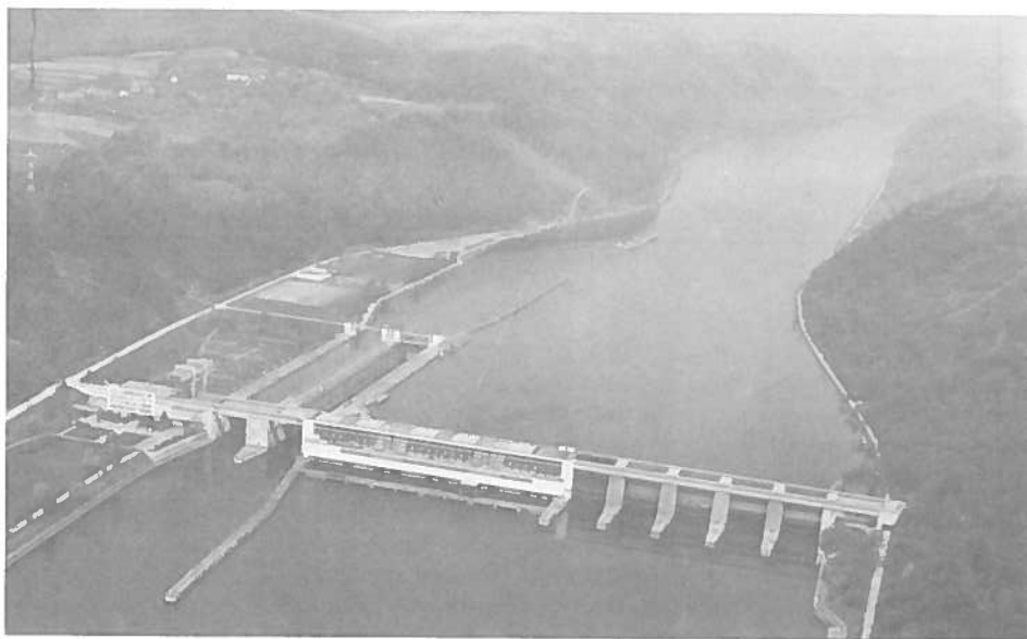
Centrale hydro-électrique d'Aschach (km 2162)
