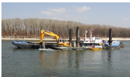
Stabilisation critical scours
