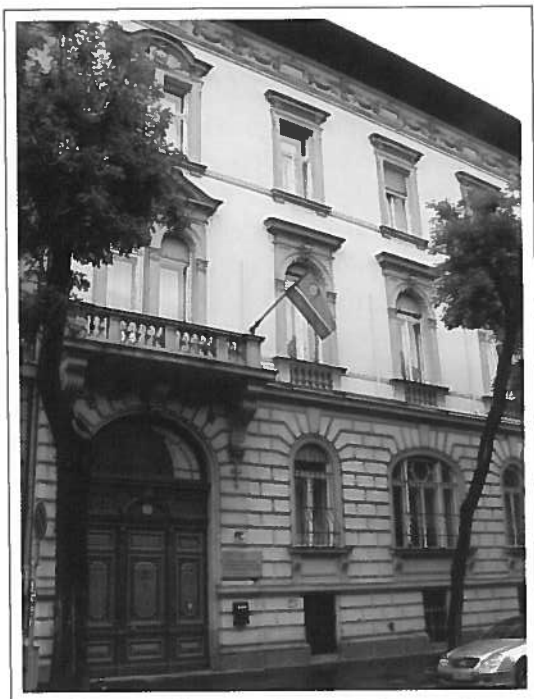
Gebäude der Donaukommission in Budapest
