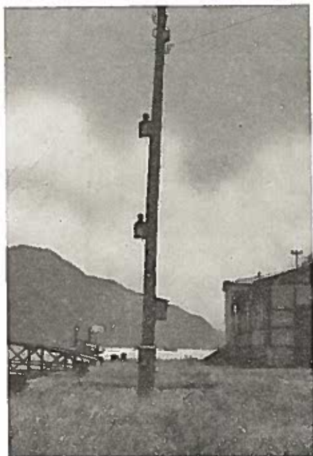
Signaux du poste Wesenufer (km 2192,849)
