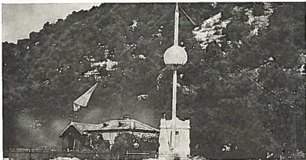
Signaux de la station Vodîța (km 951)
