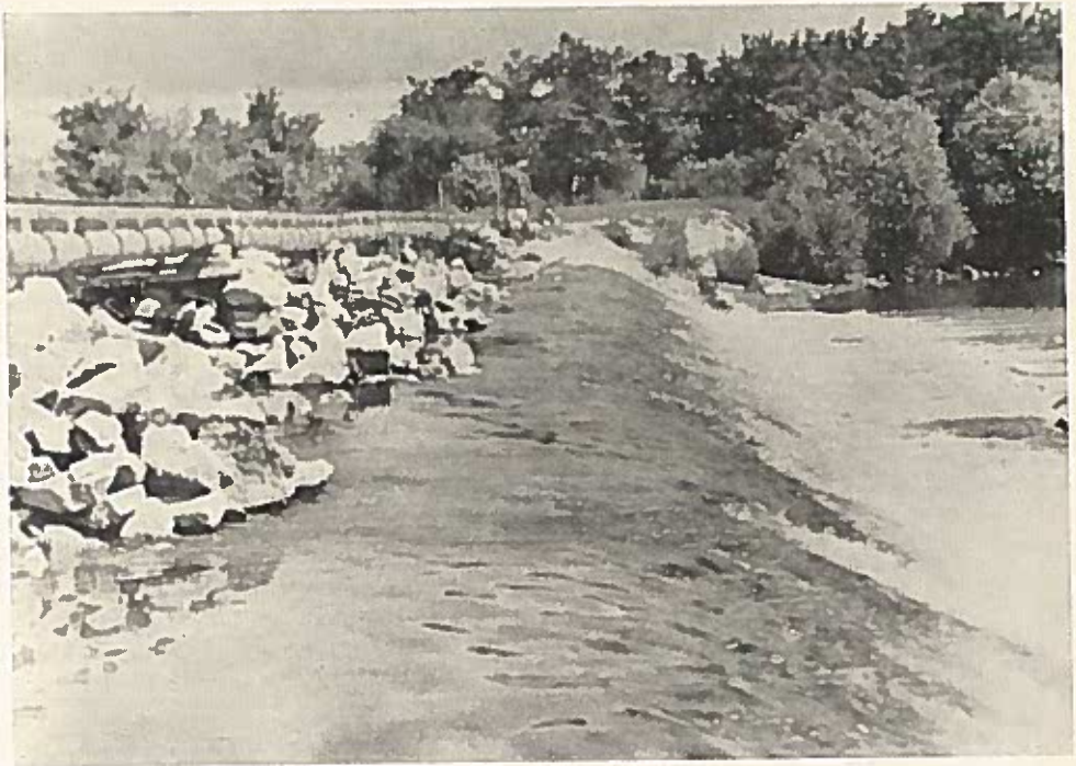
Travaux de régularisation au km 1815 de la rive gauche.
