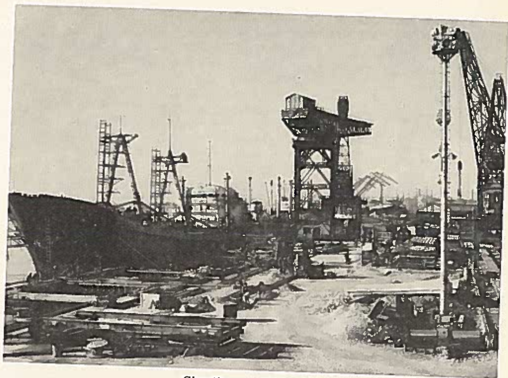
Chantier naval à Galați.
