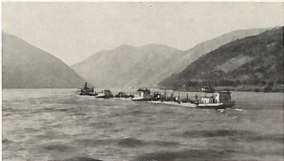
Remorquage d'un convoi dans le secteur des Portes de Fer.
