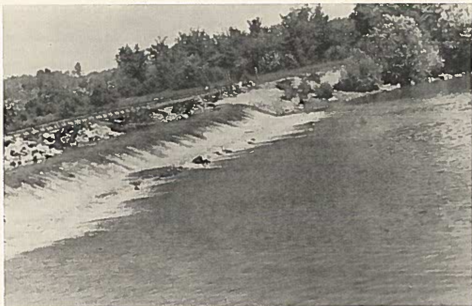
Travaux de régularisation au km 1815 de la rive gauche.
