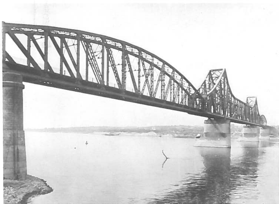
Pont sur le Danube à Cernavoda
