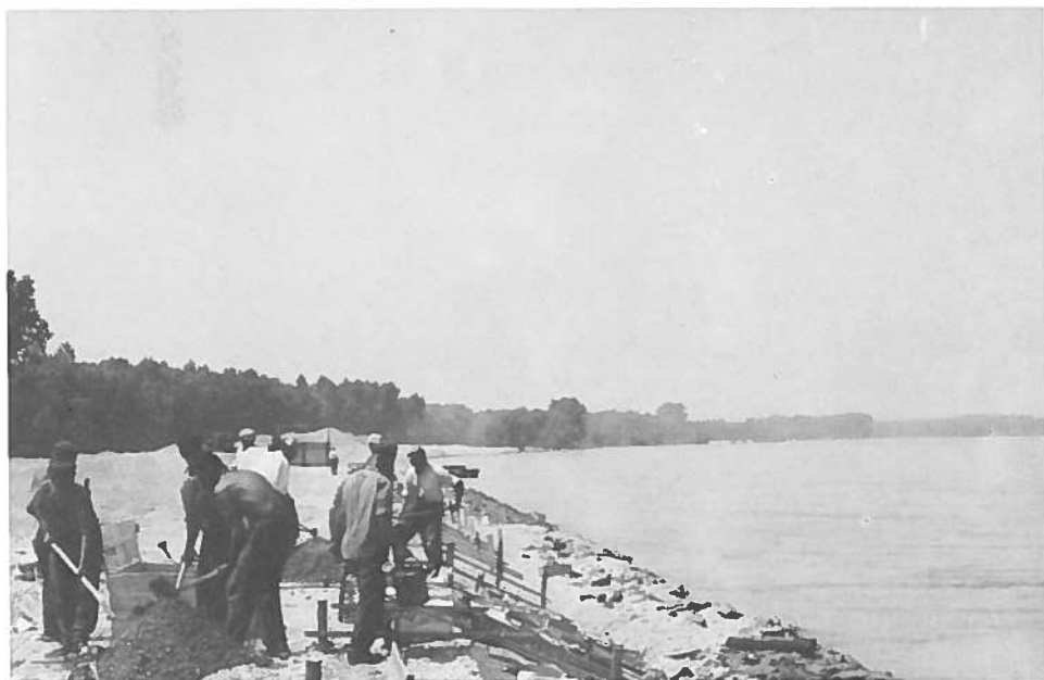
Travaux de renforcement de la berge pour la création d'un lit unique (km 1840)
