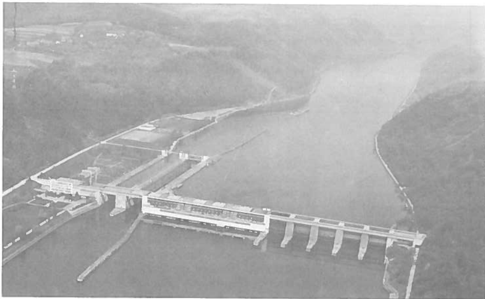
Centrale hydro-électrique d'Aschach (km 2162)
