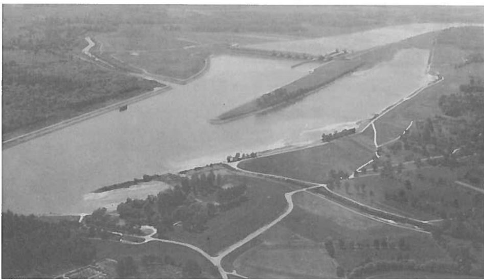
Centrale hydro-électrique d'Ottensheim (km 2146,8)
