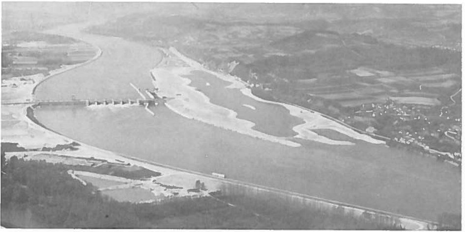
Centrale hydro-électrique de Melk (km 2038)
