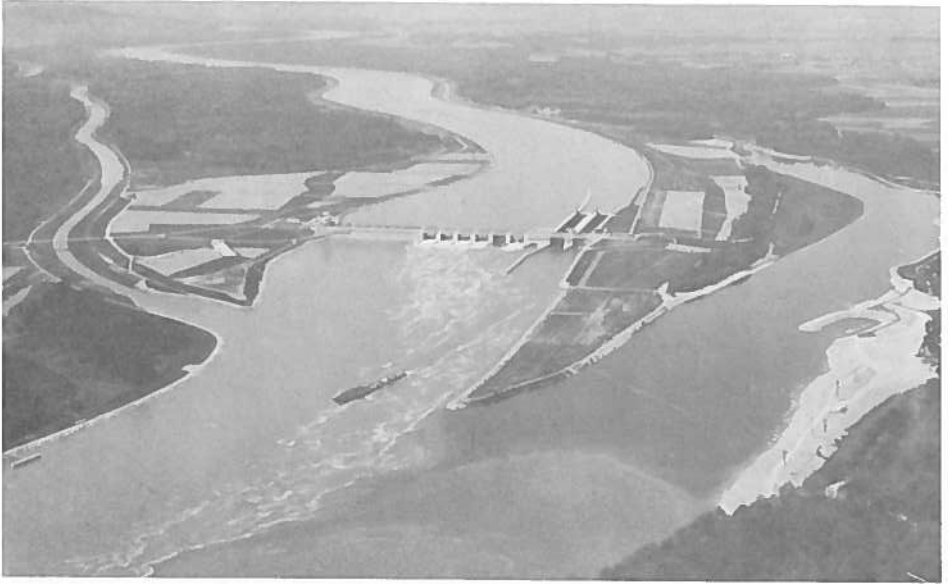
Centrale hydro-électrique d'Altenwörth (km 1980)
