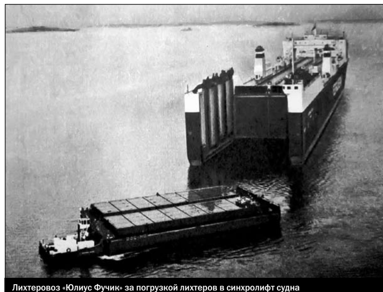
Лихтеровоз «Юлиус Фучик» за погрузкой лихтеров в синхрелифт судна
